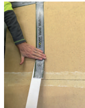
Bande adhésive appliquée sur le joint après application d'un primaire liquide ou en spray (voir p19)
