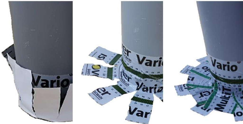
Figure 27 : Jonction entre un conduit et un écran
