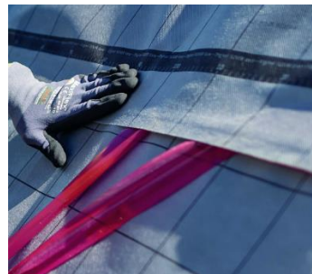
Jonction avec adhésif intégré
