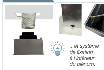
Installation du plénum après la pose du placo.
